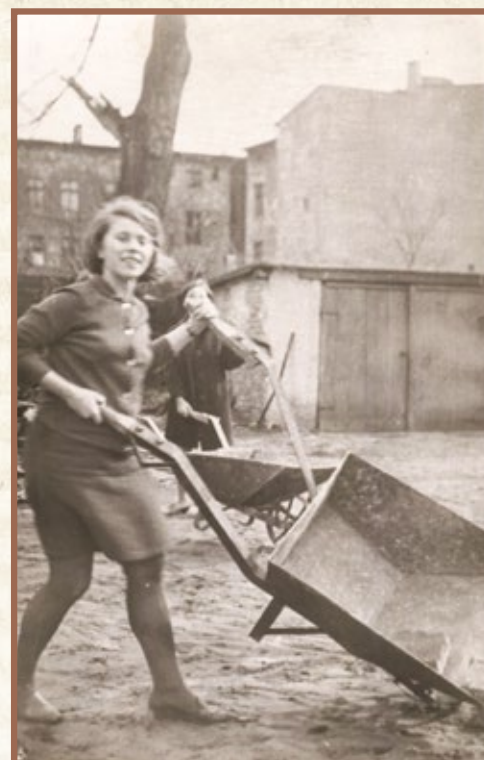
Spółeczna budowa sali gimnastycznej oraz łącznika, w którym zlokalizowano nowe sale i węzeł sanitarny
